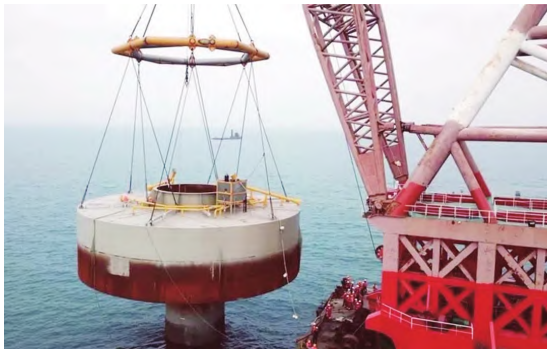
图1 桩桶复合基础
